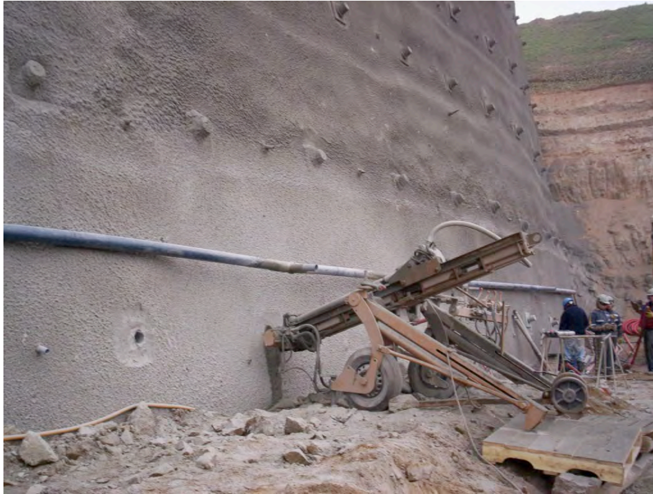
Ilustración 1: Fotografía de perforadora Mini Drill en Viña del Mar
