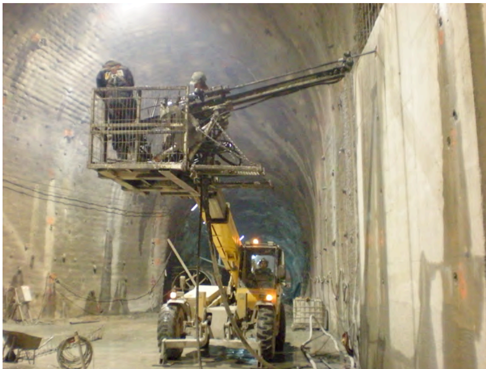
Ilustración 2: Fotografía de perforadora Mini Drill realizando inyecciones en túnel
