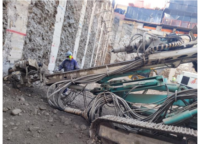
Imagen 2: Proceso de Perforación
