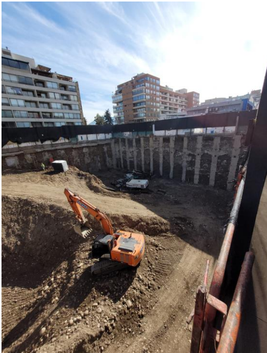
Imagen 1: Vista general excavaciones
