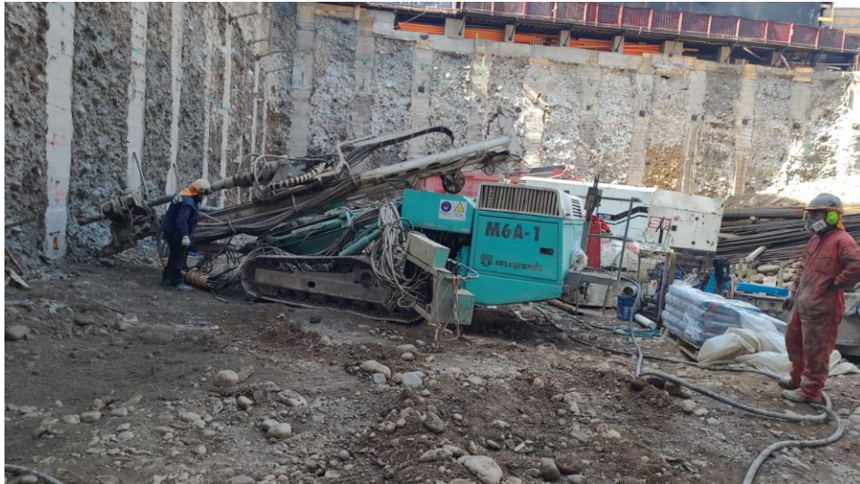
Imagen 4: Proceso de Perforación.
