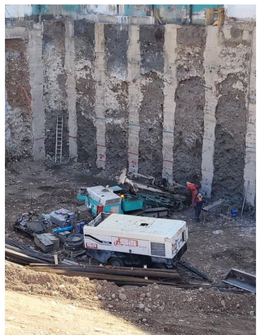
Imagen 3: Vista general proceso perforación.
