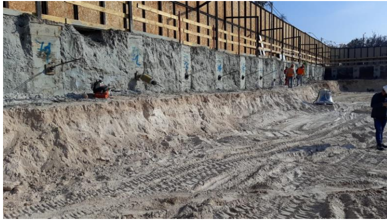
Imagen 4: Vista general proceso de anclaje.
