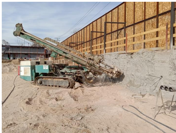
Imagen 2: Proceso de Perforación
