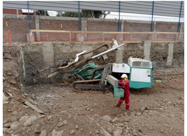
Imagen 2: Perforadora M-6 en operación
