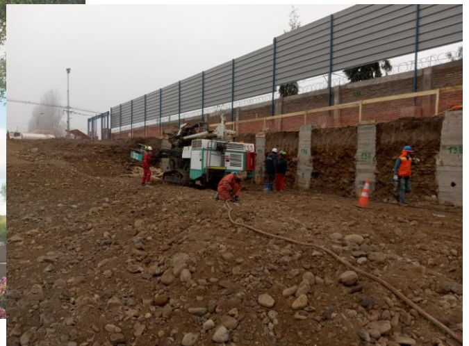
Imagen 3: Vista general de perforación
