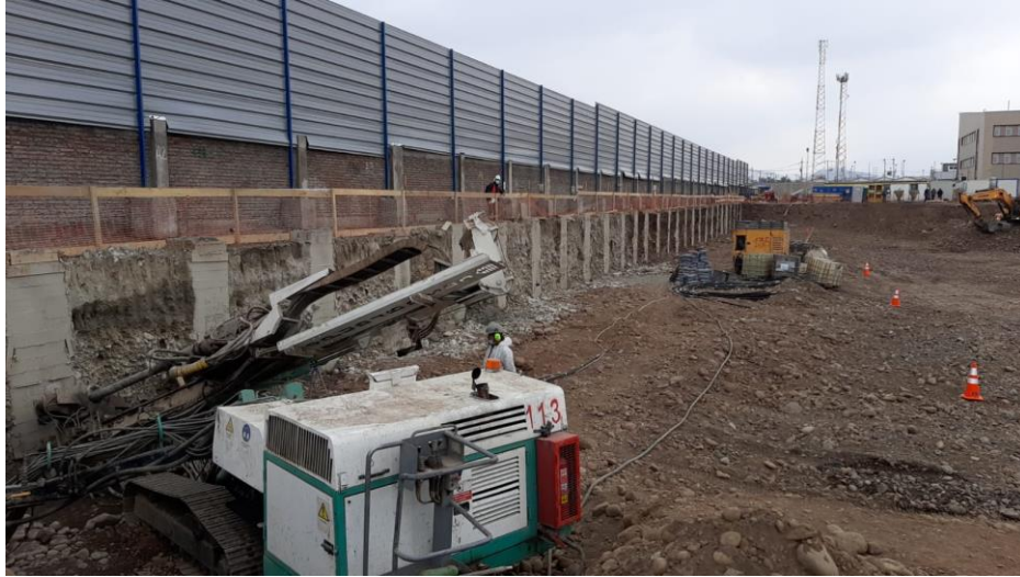
Imagen 4: Vista Anterior proceso de perforación.
