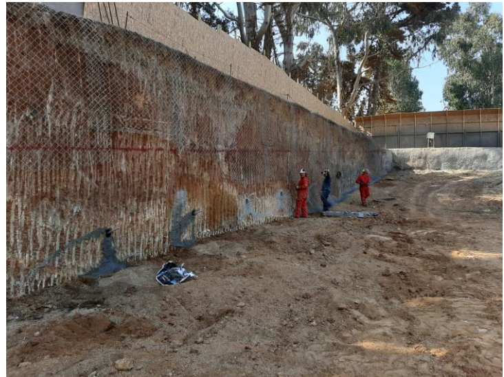
Imagen 2: Instalación Malla MFI 3500
