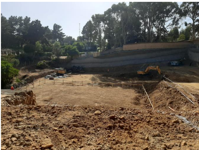
Imagen 1: Vista general excavaciones.
