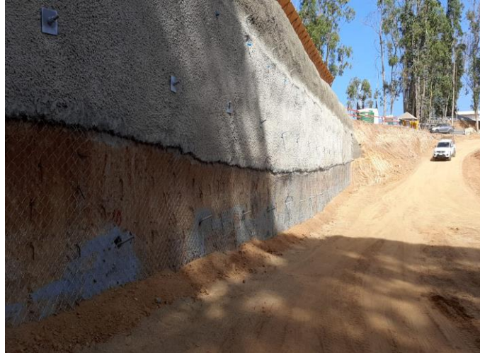
Imagen 4: Vista Instalación malla MFI 3500, Shotcrete y perno.
