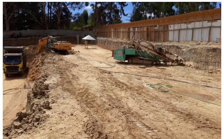
Imagen 3: Proceso de perforación.
