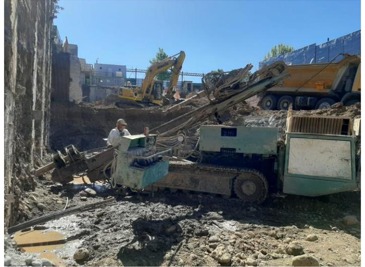
Imagen 2: Proceso de Perforación
