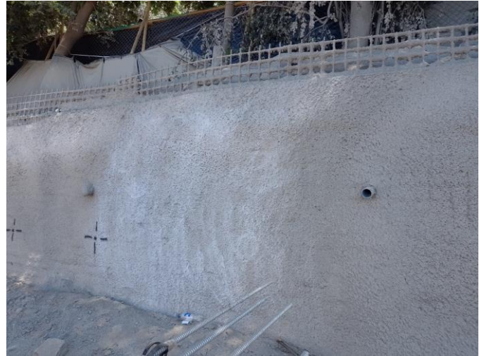
Imagen 2: Shotcrete en talud
