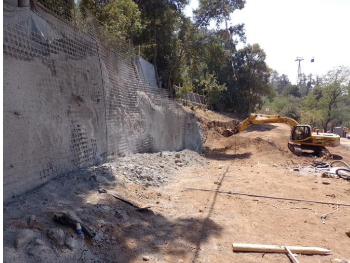
Imagen 4: Vista Instalación Malla Acma y Shotcrete
