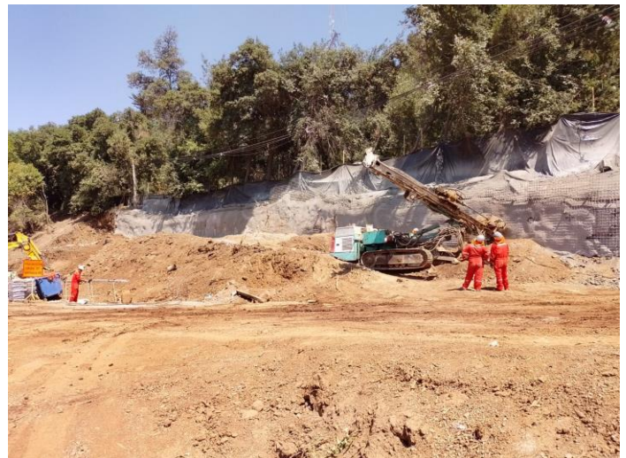
Imagen 3: Vista general de perforación.
