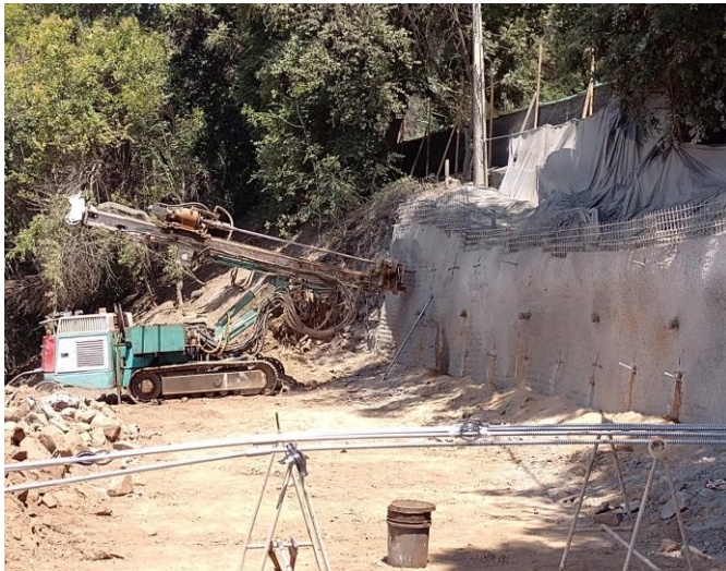
Imagen 1: Proceso de Perforación
