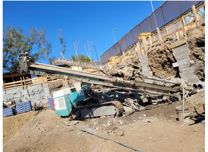
Imagen 2: Proceso de Perforación
